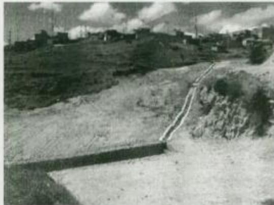
Foto N° 14. Obras de estabilización de taludes manejo de aguas superficiales, drenes provisionales.
