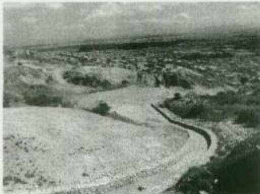
Foto N° 13 Obras de Canalización de quebrada La Carbonera estabilización de taludes, encauce de quebrada y drenajes perimetrales.
